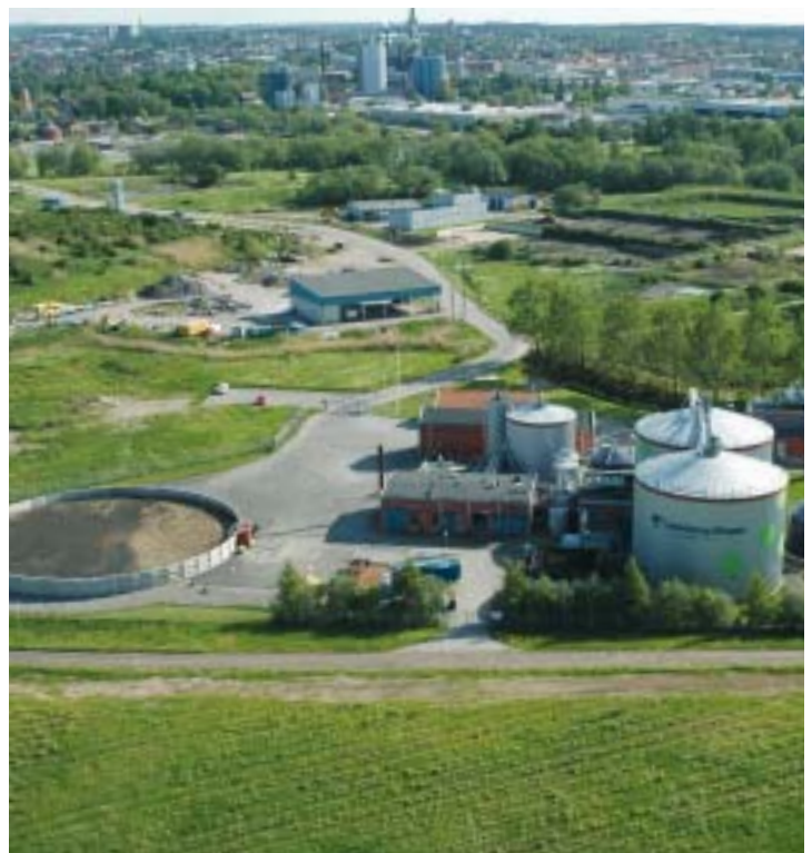
The Linköping biogas plant Photo: Svensk Biogas
